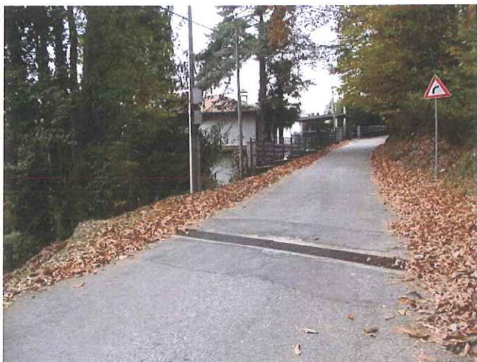
Settore della strada di Villaggio Monte Lago Alto in cui gli eventuali deflussi meteorici che defluiscono lungo il piano viario tendono a gettarsi nel versante sottostante.
