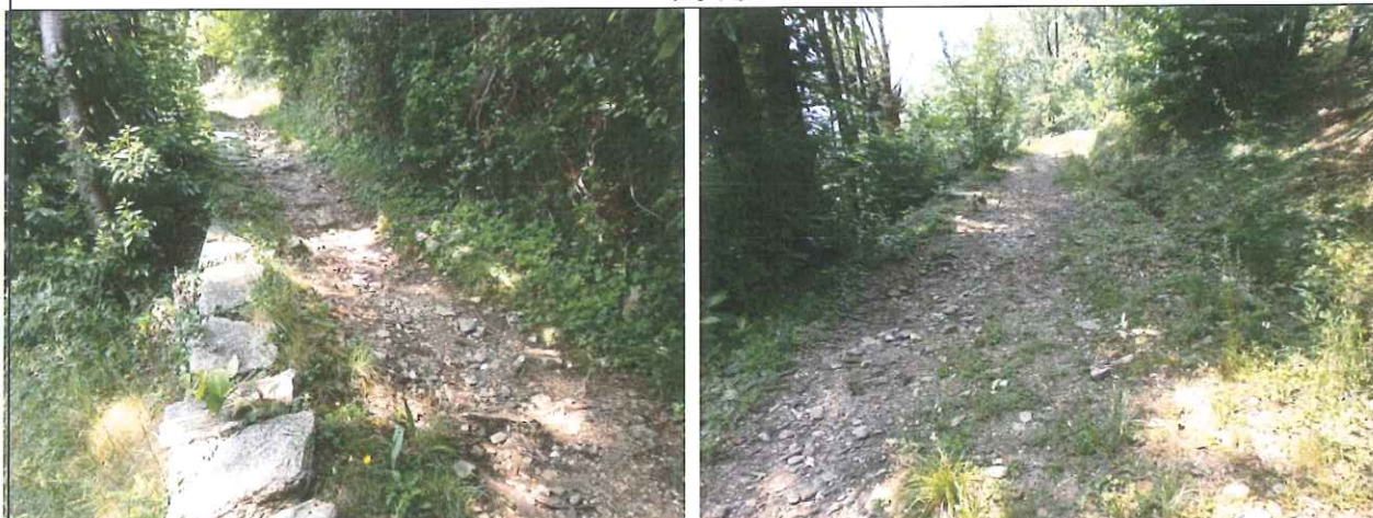
Due tratte della S.C. Ponte Donego, con evidenze di ruscellamento concentrato sul sedime.
