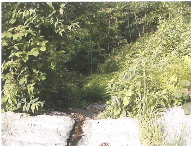
Tratta dell'impluvio immediatamente a valle dell'attraversamento della strada sterrata, in parte lastricata in massi. Anche questa tratta necessita di manutenzione e pulizia da detrito e vegetazione.
