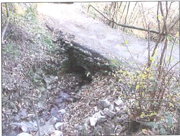
Particolare di uno degli attraversamenti ritenuti insufficienti a garantire il corretto deflusso delle acque
