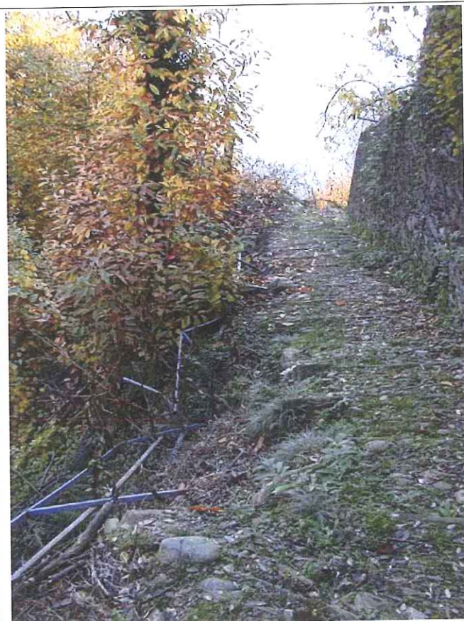
Foto che evidenziano il dissesto a carico della strada comunale del Mater, sotto Camogno, avvenuto il 19 agosto 2004 e dovuto al deflusso delle acque meteoriche lungo il sentiero e alla caduta di alberi, con conseguente franamento di materiale sciolto di copertura.
