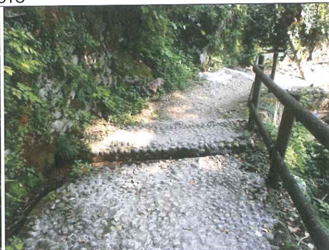
Lastricatura del sentiero Cannero-Donago e scarico a valle delle acque di sorgente.
