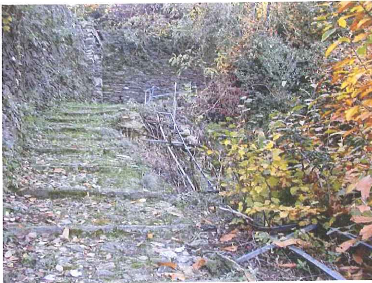
Foto che evidenziano il dissesto a carico della strada comunale del Mater, sotto Camogno, avvenuto il 19 agosto 2004 e dovuto al deflusso delle acque meteoriche lungo il sentiero e alla caduta di alberi, con conseguente franamento di materiale sciolto di copertura.
